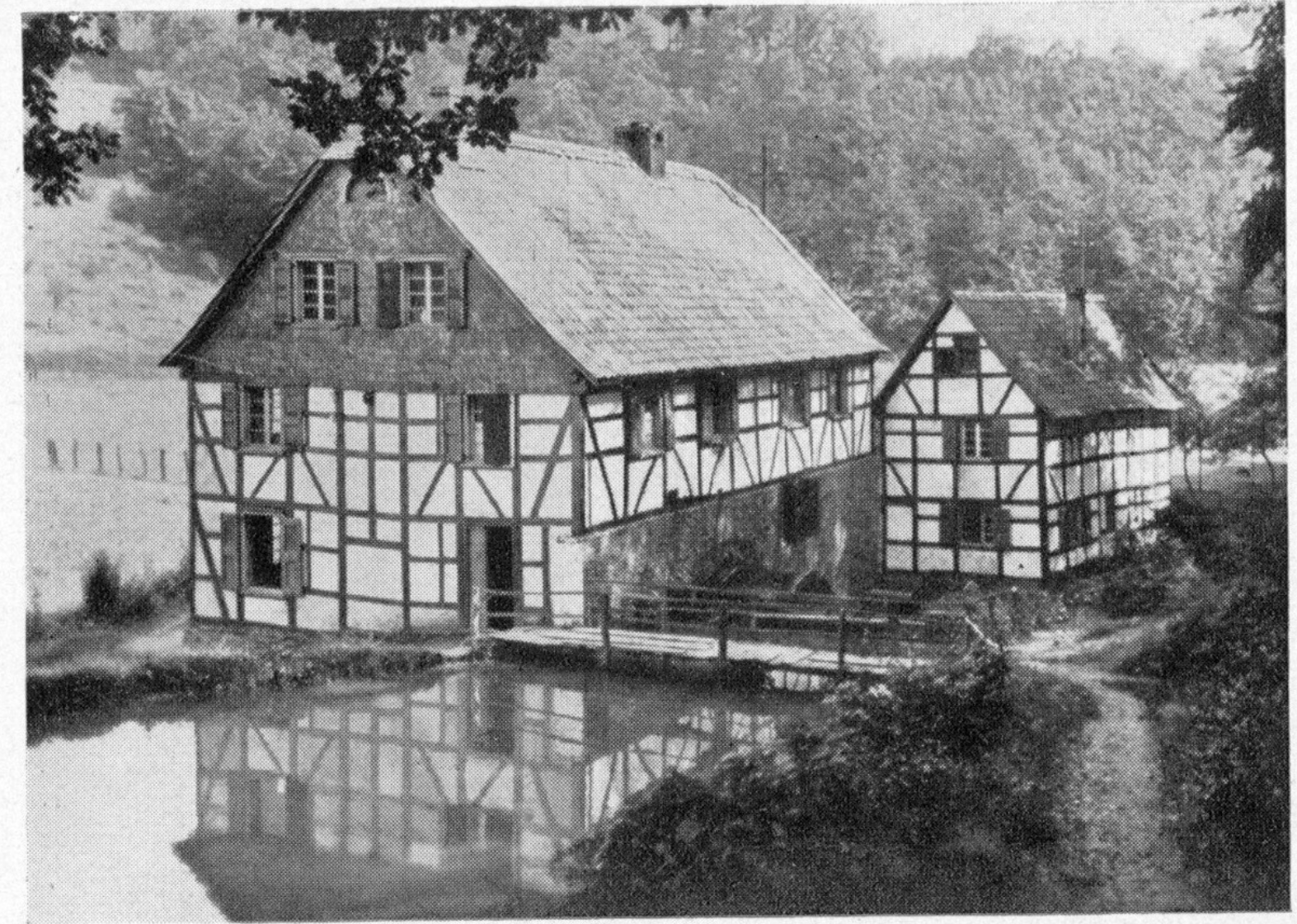
Schleifkotten im Heiderbergthal
