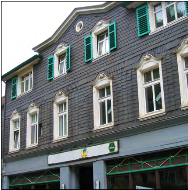
Die Dörfer Solingens entwickelten sich sehr unterschiedlich. Bescheidener Reichtum wurde gern in einer Art Bergischem Barock auch als Fassade demonstriert. Manche gibt es noch.
