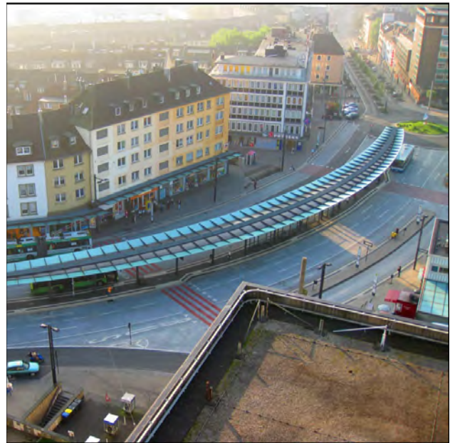
In der Planung wurde dieser gebogene Busbahnsteig „Banane“ genannt. Das Schlimme ist, der Krümmungsgrad entspricht nicht der EU-Vorschrift. Wird er jetzt abgerissen?
